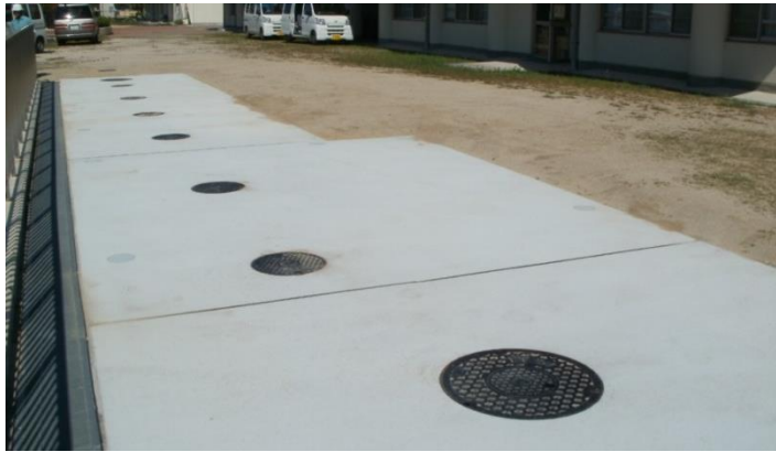
マンホールトイレの工事完成状況
