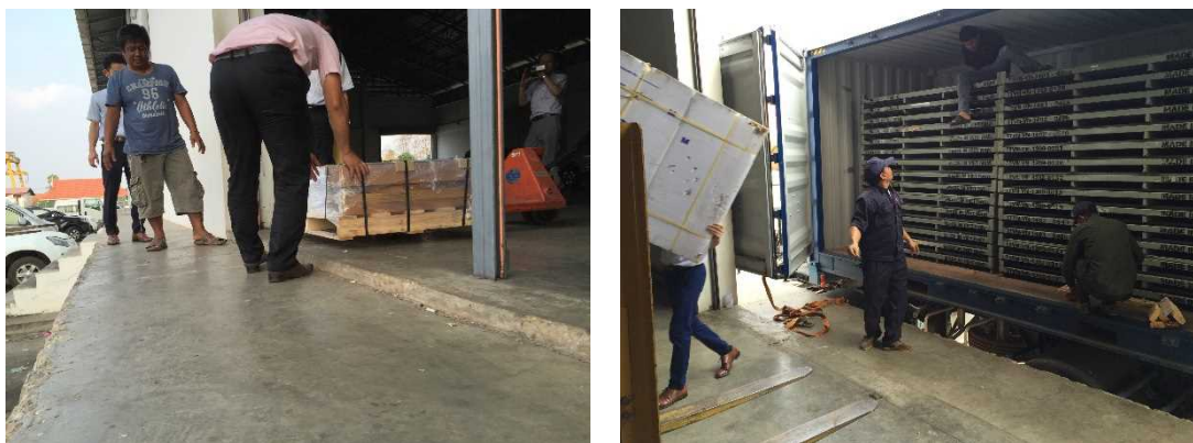
図 12 床の段差 搬出入口とトラックの段差
