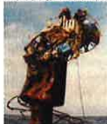
損傷した浮体式灯標
