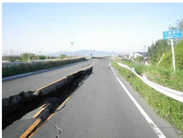
熊本地震による河川堤防の変状状況(緑川中流部)
