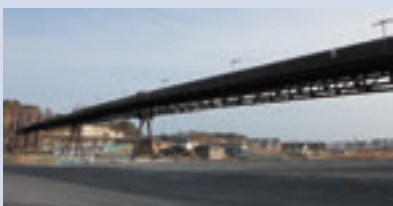
ベルトコンベア(現在撤去済み)
