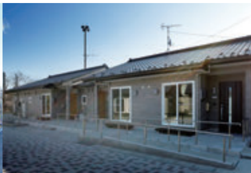
宮城県塩竈市・浦戸桂島地区13戸(H27.2(8戸), H27.12(5戸)完成)
