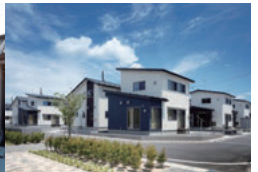
福島県桑折町・桑折駅前地区47戸(H27.5完成)
