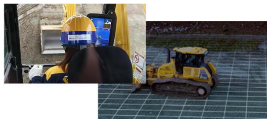
ICT建機による施工
