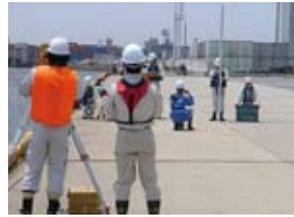
九州地方整備局、宮崎県、災害協定団体が連携し、目視による港湾施設や構造物の破損状況の点検、測量器具を用いた構造物の変位測定や沈下量の測量等を実施します。
