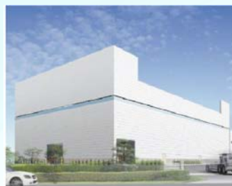
広島市西部水資源再生センター
