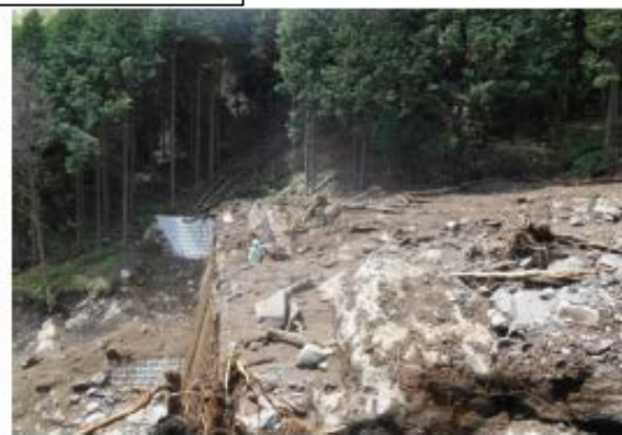
▼谷止工が流出土砂を捕捉
