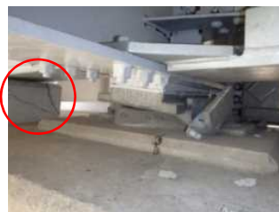
写真-6 支承の破損の状況
