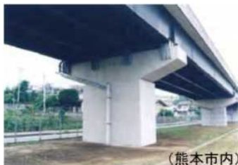
写真-3 国道3号 跨線部
