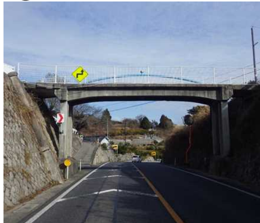
地方管理の跨道橋(未対策)
