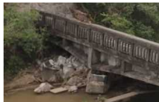
写真-2 平田・小柳線 田中橋
