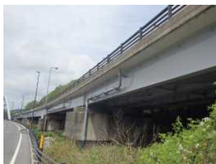
写真-4 阿蘇口大橋 (国道57号)
