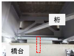
写真-5 アンカーバーのイメージ
