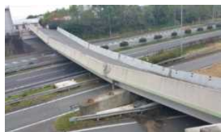
写真-1 県道小川嘉島線 府領第一橋
