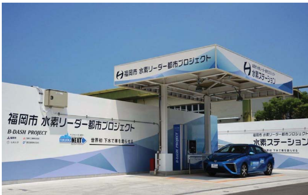
水素ステーション(水素供給設備)
