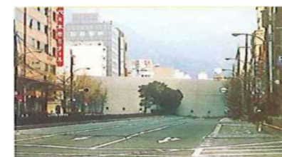
倒壊し避難路を塞いだ建築物
