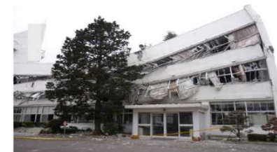
地震により倒壊した大規模建築物
