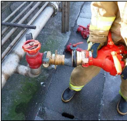
Step1 65mm消火栓へのYゲート取付
