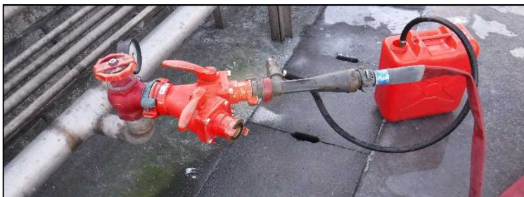
Step2 火災の規模に応じて泡用「ラインプロポーションナー」を接続
