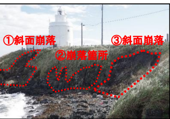
①斜面崩落 ②崩落箇所 ③斜面崩落 北側斜面の法面崩落状況 【平成28年8月19日 撮影】
