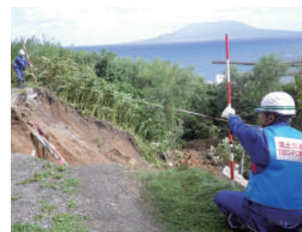
TEC-FORCEによる被災状況調査
