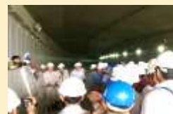
平成23年10月 合同現場見学会（ベトナム）
