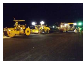
(老朽化した滑走路舗装の改良)
