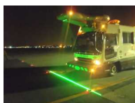
(基本施設点検実施状況)
