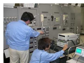
(航空保安施設点検実施状況)
