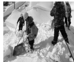
屋根雪下ろし時の転落防止 (命綱着用)
