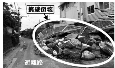
小規模造成宅地の被害
