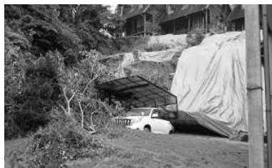
大規模造成宅地の滑動崩落
