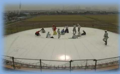
エアードーム工法
