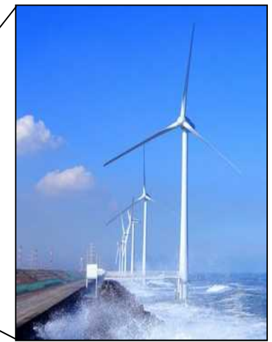
洋上風力発電施設
