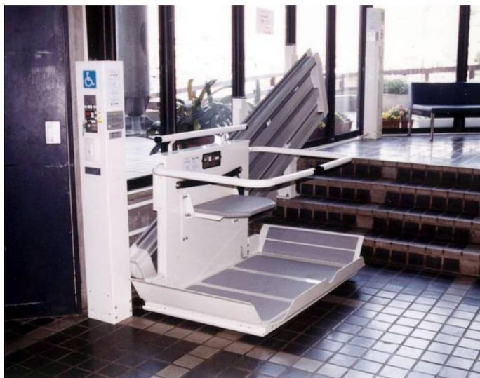
・既存施設のホール部分の階段に設置した斜行型段差解消機
