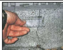
水平器による柱の傾きの計測
