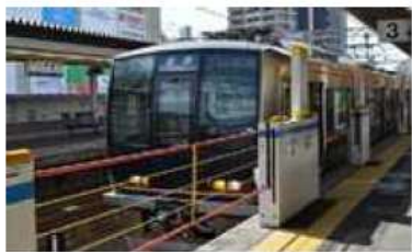
○昇降ロープ式ホーム柵（支柱伸縮型）
