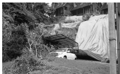
大規模造成宅地の滑動崩落
