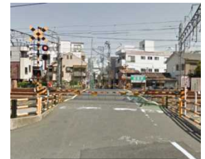
伊勢崎線21号踏切 (H25年度・足立区)
