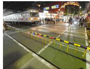
尾山台1号踏切 (H25年度・世田谷区)
