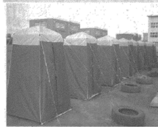
東日本大震災で活躍した宮城県東和郡市の災害用マンホールトイレ
