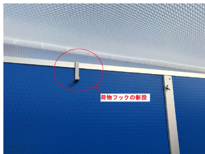
荷物フックの新設
