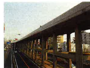
FRP製高欄設置状況
