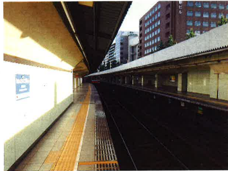
緑地公園駅現状
