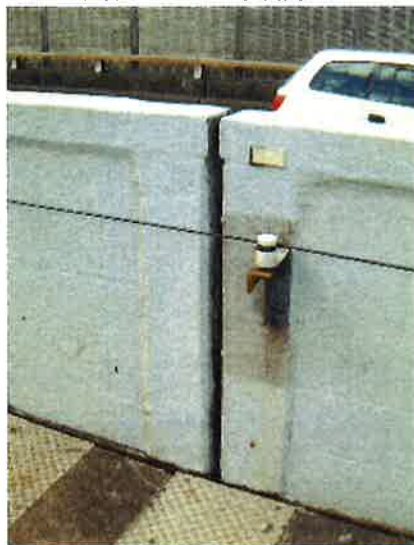
既設ブロック高欄
