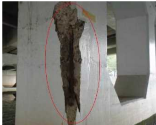
コンクリート剥離・鉄筋露出
