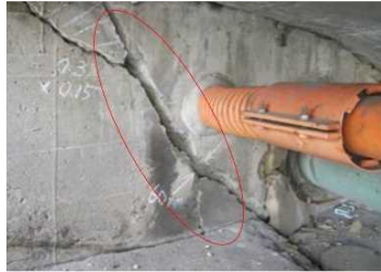
橋台のひび割れ
