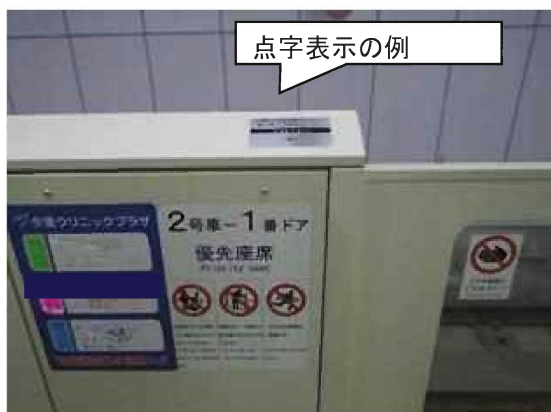
参考 3-1-5 : ホームドア・可動式ホーム柵の例
