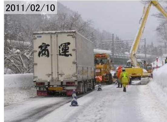
写真1 雪庇処理時に伴う通行規制の状況（秋田県側）
