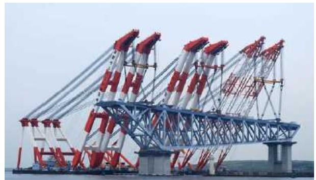
図2-1-5 架設完了(起重機船3隻)
