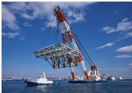
図2-3-3 起重機船による吊上げ運搬状況写真
