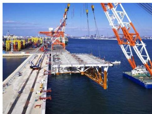
図2-3-4 仮受杭への据付状況写真
