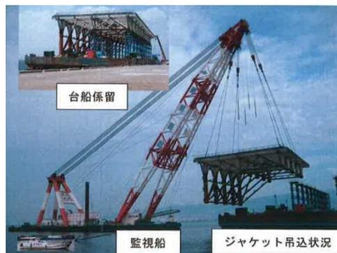
図2-3-2 台船からの吊上げ状況写真
