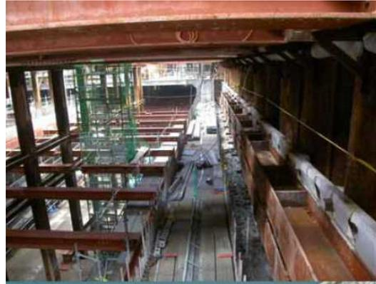
図3-4-2 盛り変え梁設置状況写真
