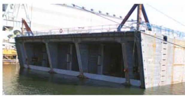
図1-5-1 沈埋函の形状写真
