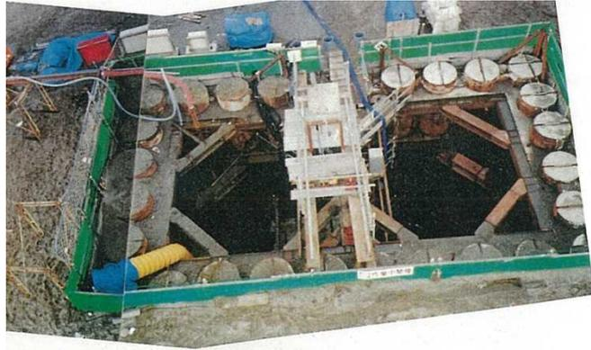
図3-3-5 既設鋼管矢板にSMW工法を併用
