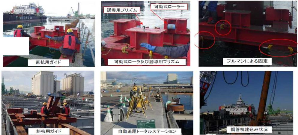
図1-6-5 可動式ローラー付鋼管杭ガイド
