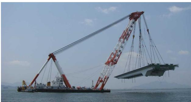
図2-4-2 橋梁上部工運搬状況
