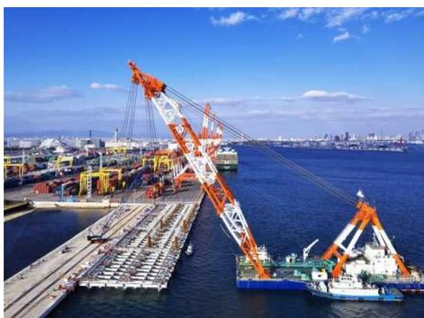
図2-3-5 ジャケット据付状況写真
