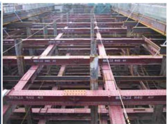
図3-2-3 支保工の施工状況
