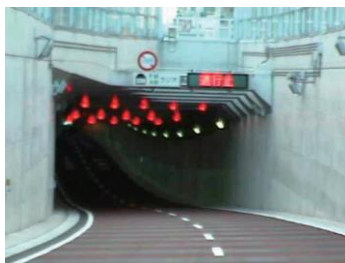
坑口部フラッシング**
