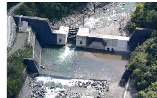
砂防堰堤等による土砂流出の調節と下流が必要な土砂の安全な流下
