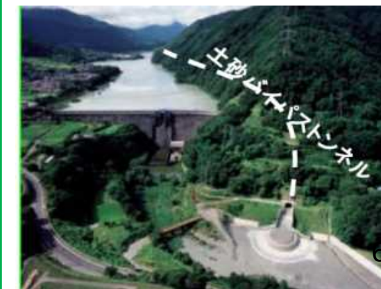
河道や海岸に配慮したダムからの土砂供給
