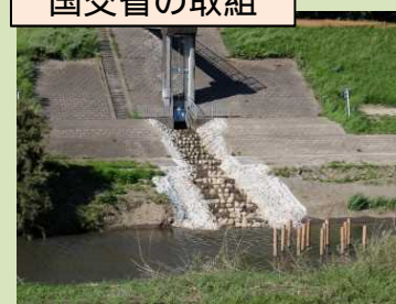
河川と流域水路との連続性を再生する樋管の落差解消
