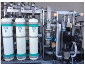
③膜処理設備
