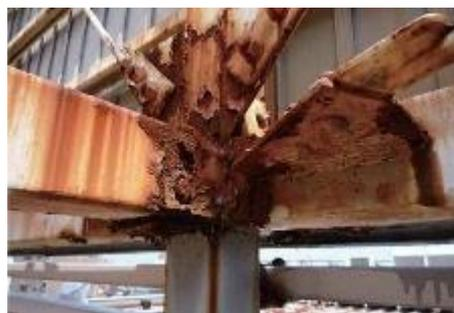
老朽化により腐食した屋上広告物の骨組み
