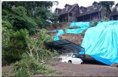
造成地の再度災害(雨による造成地末端の崩壊)
