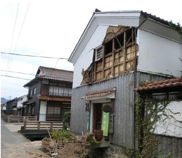
白壁土蔵群における外壁の崩落状況(鳥取県倉吉市)
