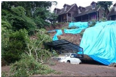
造成地の再度災害(雨による造成地末端の崩壊)
