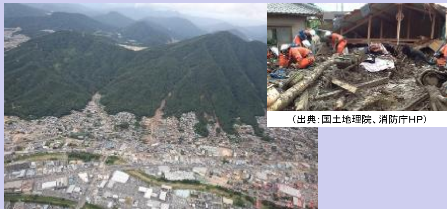
(出典：平成26年8月豪雨による広島県で発生した土砂災害への対応状況/国土交通省/平成26年10月31日)
