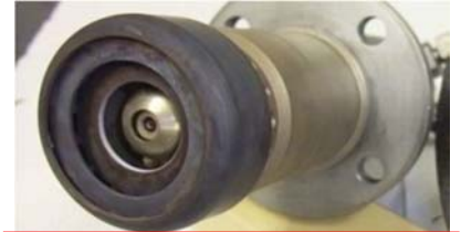
既存燃料ノズルの焼損
