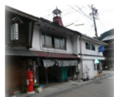
建物修景整備
