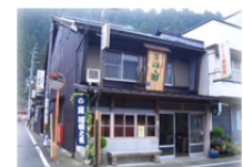
空き家活用実験
