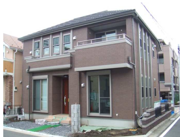
超長期住宅先導的モデル事業 (神奈川県横浜市)
