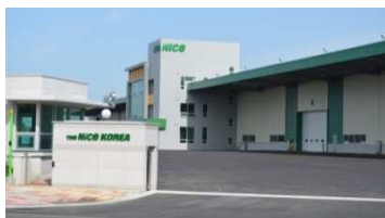
釜山新港総合物流センター(韓国)
