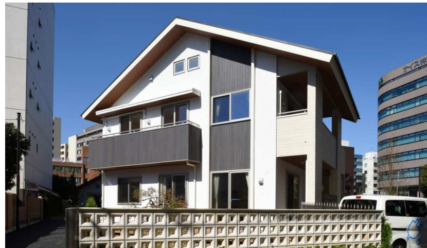
■スマートウェルネス住宅2号棟
