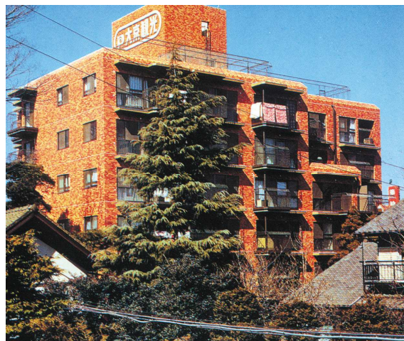
「ライオンズマンション高井戸」の タイル貼り
