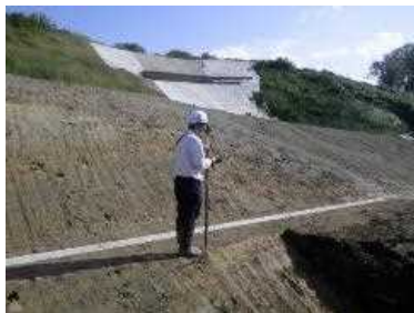
○ 出来形確認の状況
