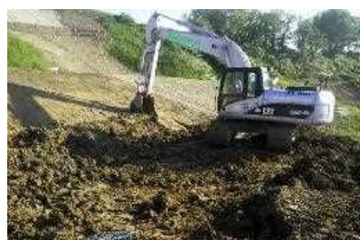
○ ICTバックホウによる法面整形
