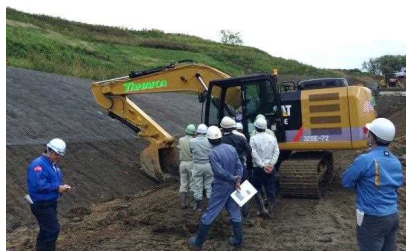
○ ICT技術活用工事現場研修
