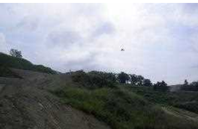
○ UAV(ドローン)による施工前の測量(9月12日撮影)
