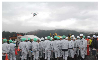
ICT活用土工実証検討会 (ICT土工現場勉強会) (秋田県建設業協会、東北測量設計協会、東北地方整備局)
