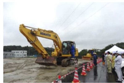
i-Construction「ICT見学会」(宮城県建設業協会)
