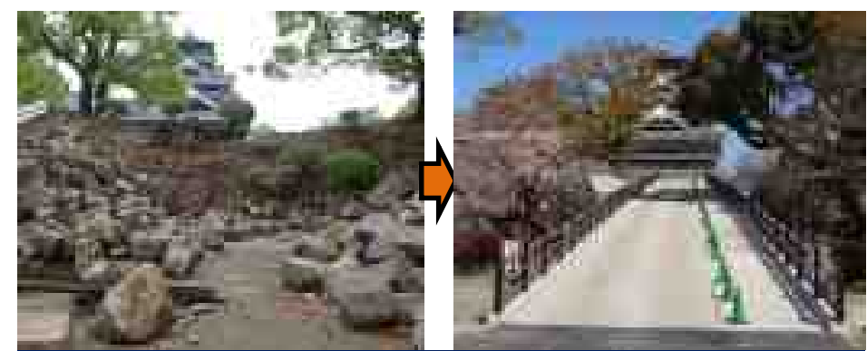
8月～H29.3月 天守閣等場内中心部への進入口となる頼当御門について、崩壊した石垣を撤去し、工事用通路設置を完了
