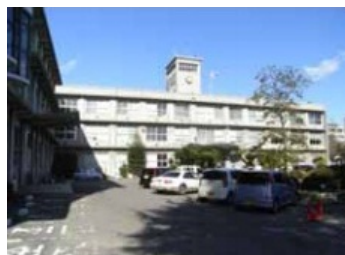
昭和29年竣工 市役所本庁舎の 建て替え
