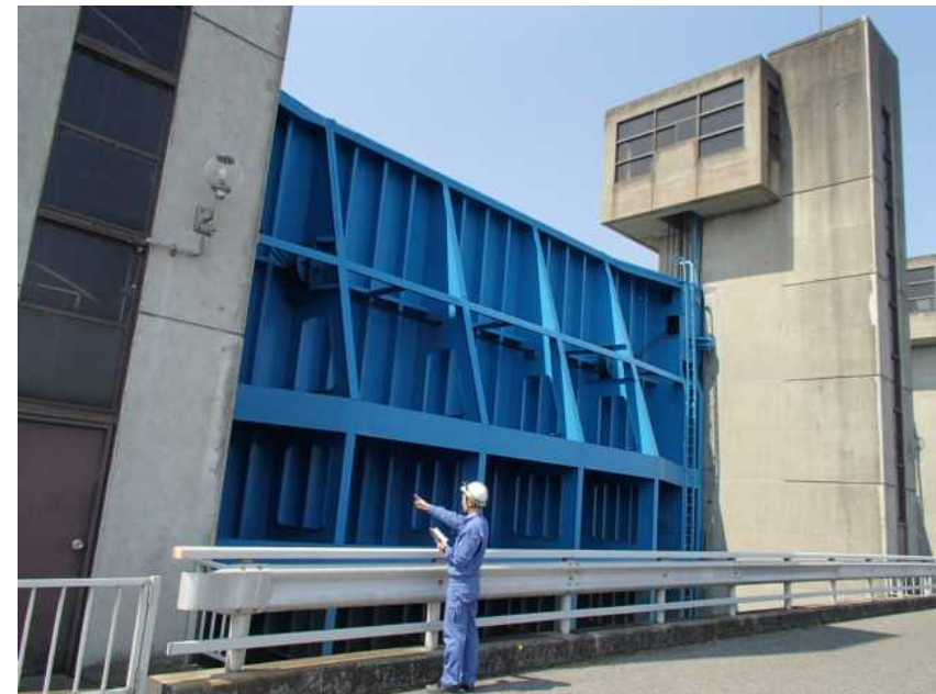
目視による臨時点検 (水門)
