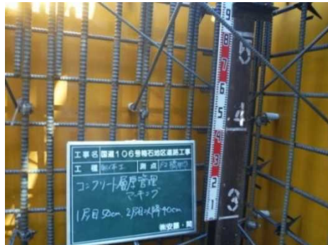
層厚管理(組立架台へのマーキング)
