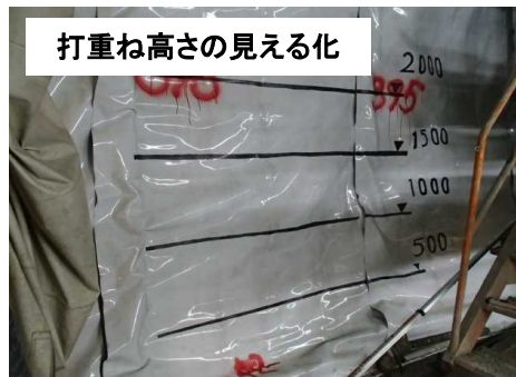
打ち重ね高さを防水シートにマーキング
