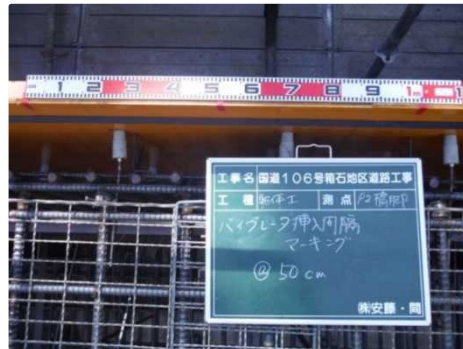
バイブレーター挿入間隔マーキング(@50cm)
