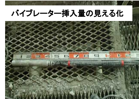
打ち重ね高さのマーキングを使用し、前層へ10cm挿入
