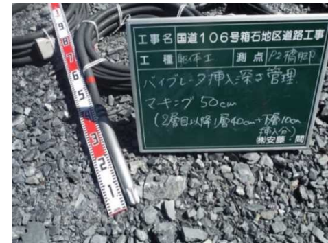
バイブレーター挿入長さ管理(マーキング層厚+10cm)
