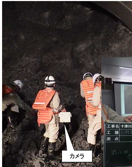
カメラを用いた岩判定実施状況 (切羽)
