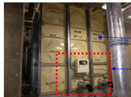
緊急遮断弁(感震)
