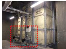
緊急遮断弁(感震)
