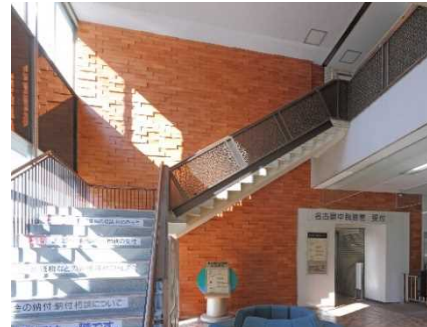
国土交通省 名古屋国税総合庁舎 （玄関ホール壁）
