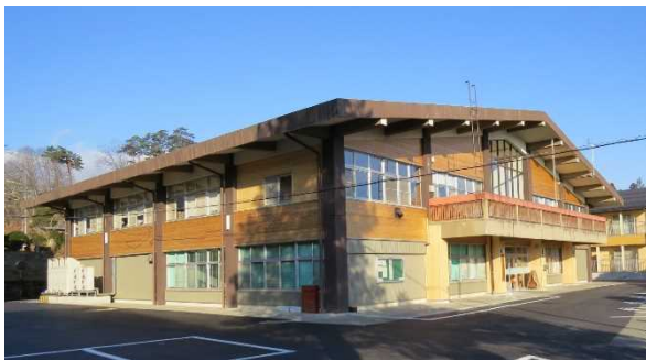
農林水産省 飛騨森林管理署庁舎 （柱、天井、壁）
